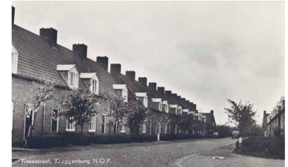
Finsestraat, Kraggenburg (oorspronkelijke situatie)
