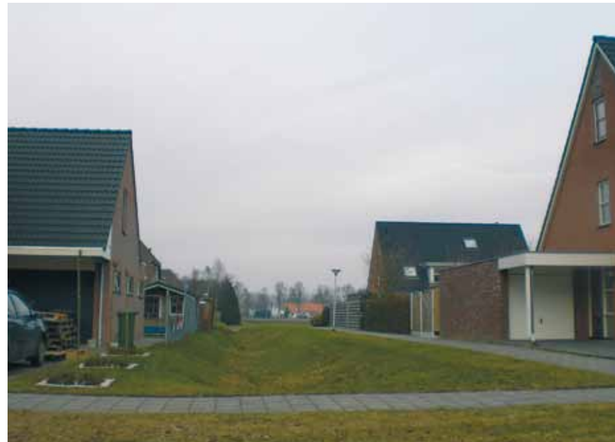
Bestaande wadi in de nieuwbouwwijk van Creil
