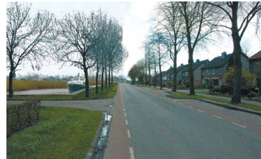
Rutten, vizier vrijgehouden, water inbrengen
