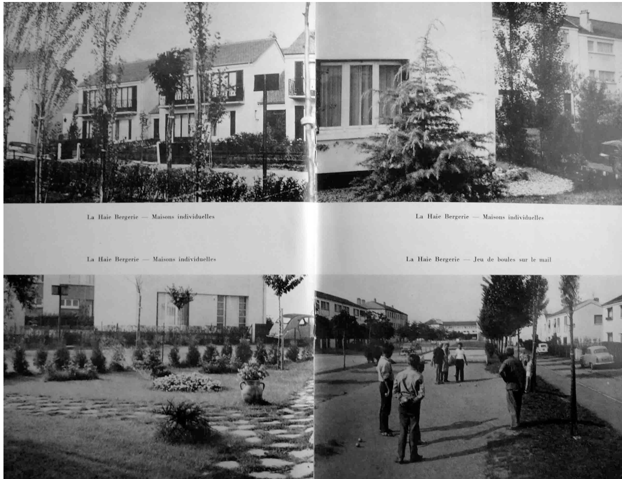
Figure 6.1: The single-family home development of La Haie Bergerie (Source: J. Riboud, La maison individuelle et son jardin dans la ville nouvelle. Un récit sur la création de La Haie Bergerie à Villepreux (Yvelines) (Paris: Mazarine, n.d.). CAC 19840342/229).
