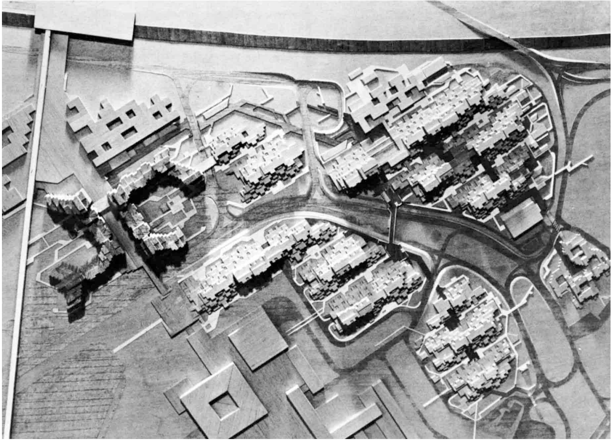
Figure 6.30: Model of housing project for Pont de Bois (Lille Est) by Alexis Josic, 1973 (Source: “Habitat intermédiaire: individualisation du collectif où collectivisation de l’individuel?” Architecture Française no. 391 (1975): 58).
